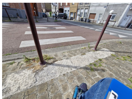
Bandes podotactiles abîmées
