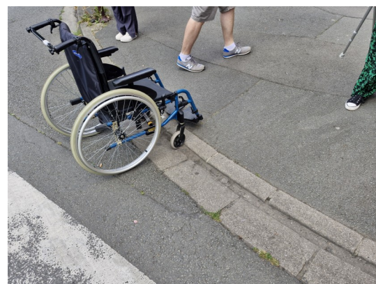
Trottoir trop haut
