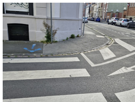
Bandes podotactiles manquantes
