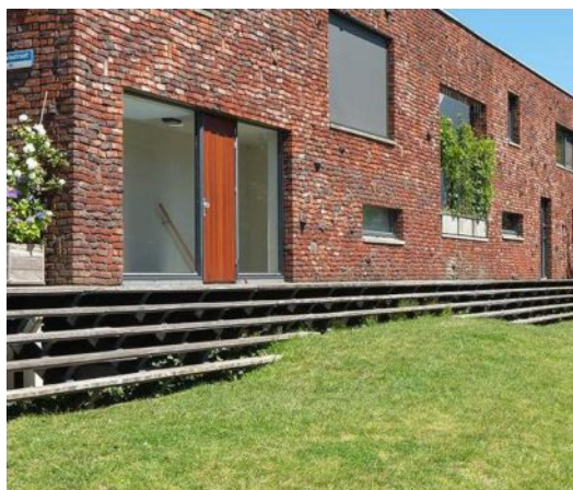
Figure 12 : Gestion de la partie visible en emmarchement, Vondel parc Mecanoo – Source : CPAUPE
