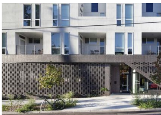
Figure 14 : Traitement d'une façade de parking en RDC, Denver ©Mérédien 105 – Source : CPAUPE
