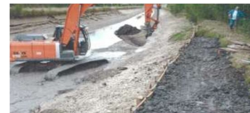
Figure 19 : Mise en œuvre de confortement avec tunage (Source : CETMEF – 2010)
