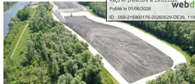
Figure 23 : Ressuyage gravitaire de sédiments sur le site de transit de Château l'Abbaye (Source : VNF)
