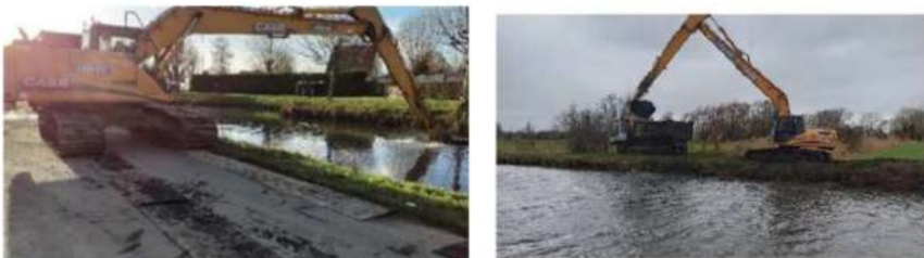
Figure 11 : Photographies du matériel de dragage pour les travaux d'Audruicq Phase 1 (source : BIOTOPE)
