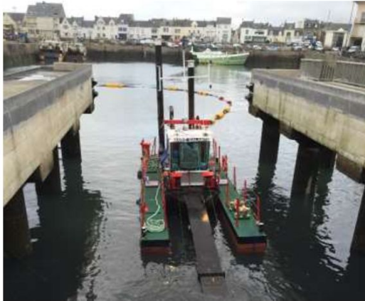
Figure 8 : Atelier de dragage hydraulique - Drague aspiratrice stationnaire (DAS) et sa conduite de refoulement
