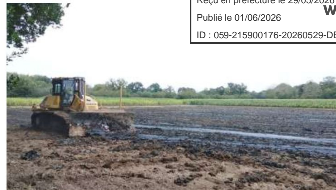
Figure 15 : Mise en œuvre d'un épandage de sédiments (Source : ETPB de la Rance – IDRA)
