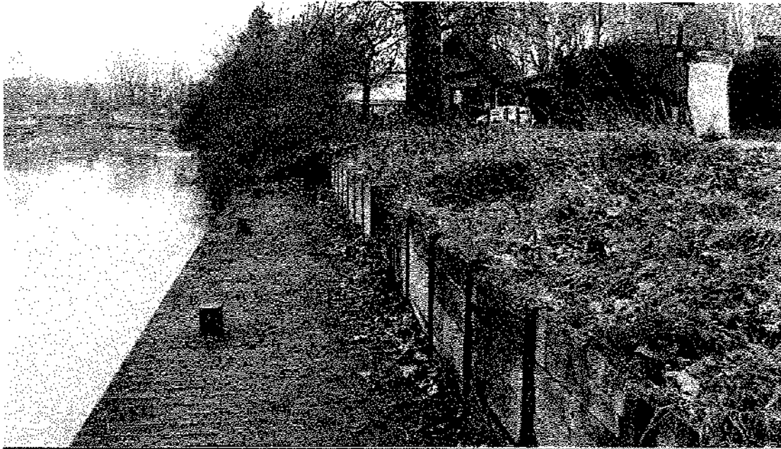
Vue générale de l'équipement d'accostage
